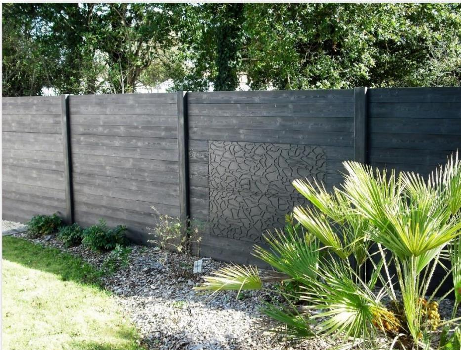
**Aspect** : La plaque béton présente un côté esthétique (fond de moule) et un côté taloché (dessus de moule) bulleux et rugueux. Ce
